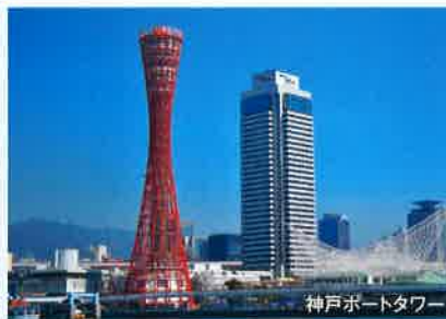
神戸ポートタワー
